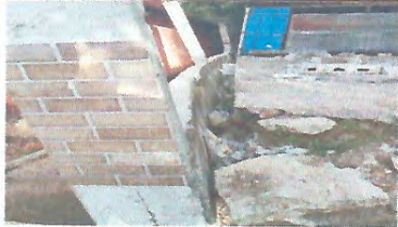
1. MEJORAMIENTO DE MURO DE CONTENCIÓN CON 3 HILERAS DE BLOCK, MALLA Y TUBO GALVANIZADO
