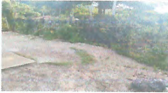
MEJORAMIENTO CON MALLA EN EL LADO PONIENTE Y TRES HILERAS DE BLOCK
